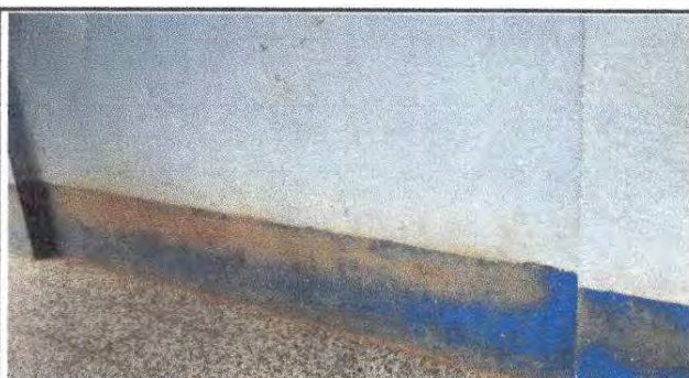
Foto 15: Pintura en muros interiores del modulo 2
