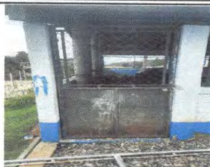
Foto 2: Mantenimiento de estructura: lijado y aplicación de pintura en puerta de metal del módulo 2 cocina
