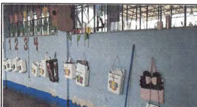
Foto 16: Pintura en muros interiores del modulo 1
