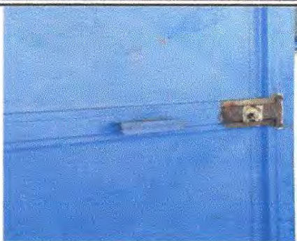
Foto 1: Mantenimiento de estructura: Sustitución de Chapa yale en puerta de aula módulo 1
