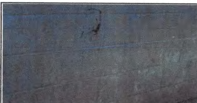
Foto 18: Pintura en muros interiores modulo 4
