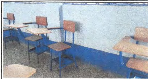
14: Pintura en muros interiores del modulo 1
